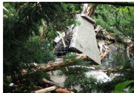
流出した床板
