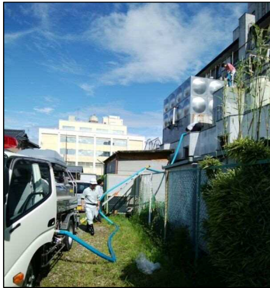
高所受水槽への給水車からの応急給水状況
