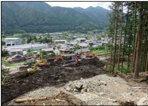
土砂撤去 金子谷（下呂市萩原町上呂地内）
