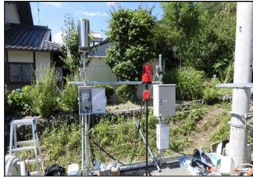
土石流センサー及び雨量計設置 金子谷（下呂市萩原町上呂地内）
