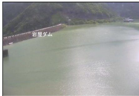
洪水時最高水位に近づく貯水池 (7月8日15時半頃)
