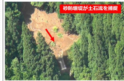
土石流の捕捉状況 （国土交通省砂防部HPより）
