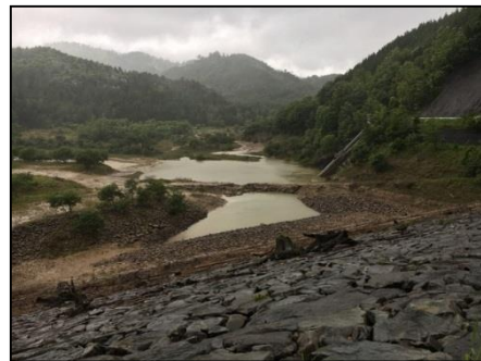
平常時の宮川防災ダム
