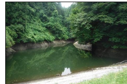
防災重点ため池（緊急点検時）
