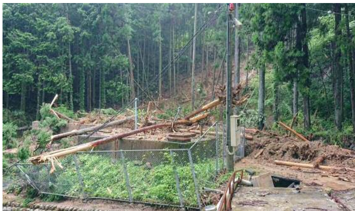
関市 上之保地内 船山配水池への土砂流入
