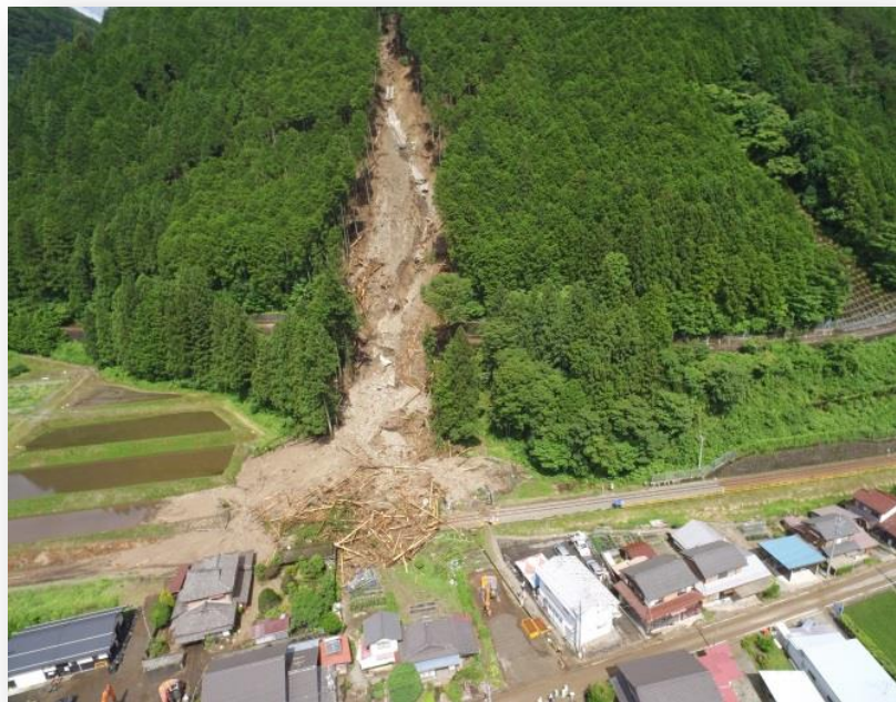
下呂市萩原町上呂地内 JR高山本線 土砂崩壊状況
