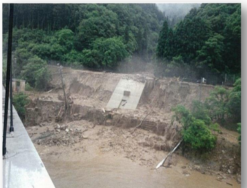
飛騨市宮川町牧戸地内 JR高山本線 土砂崩壊状況
