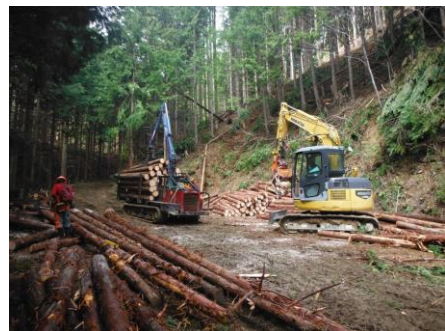
土場での仕分け作業
