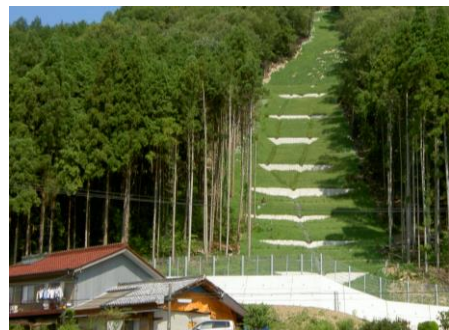
災害関連復旧治山事業
