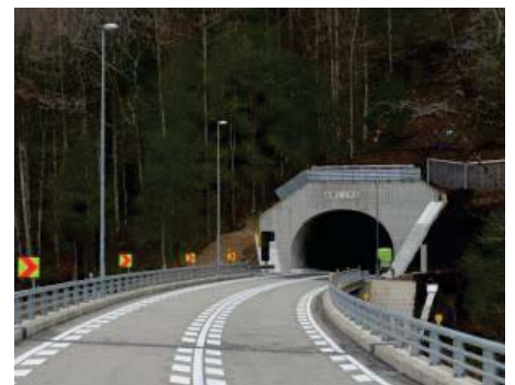
施工後【写真②】
