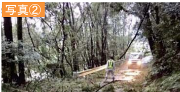
台風21号通過後の旧道（平成30年9月）
