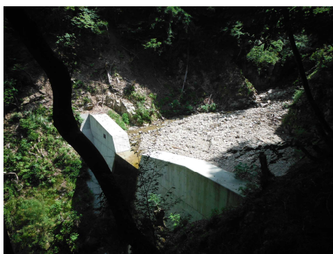
治山ダム工による土砂の捕捉状況
