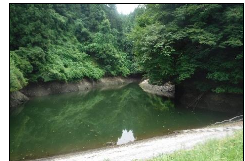
防災重点ため池 (緊急点検時)
