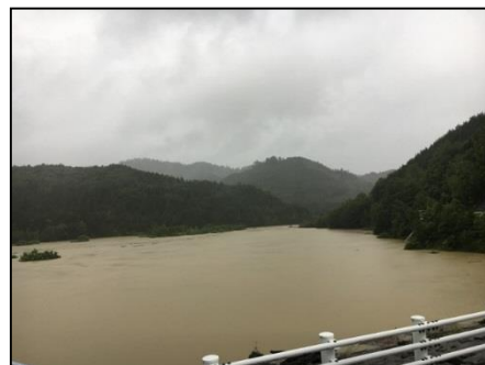
7月豪雨時の宮川防災ダム
