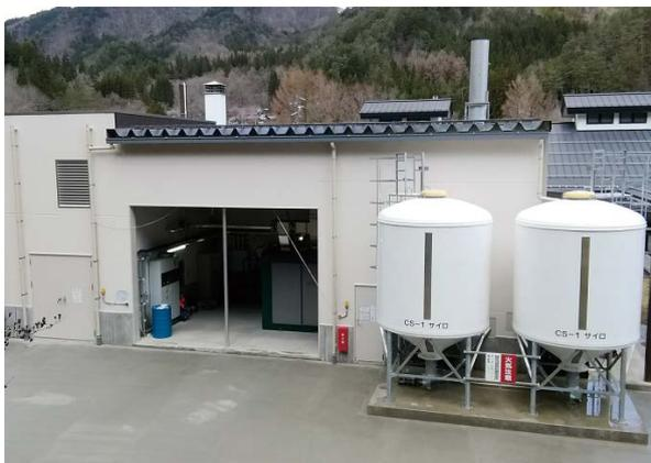
温泉施設に導入された木質ペレットガス化熱電併給施設(高山市)
