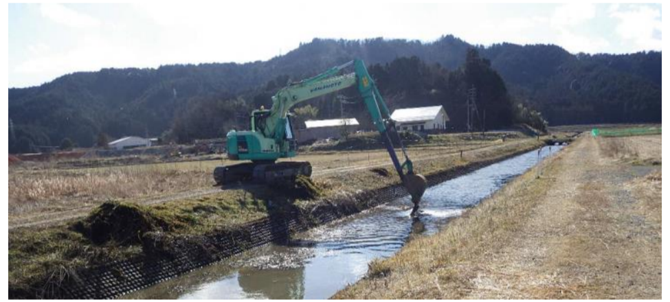
河川内の藻およびゴミの撤去の状況(管瀬川 揖斐川町)
