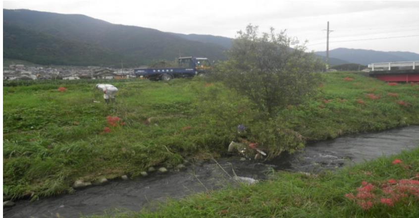
樹木伐採の状況(杭瀬川 池田町)
