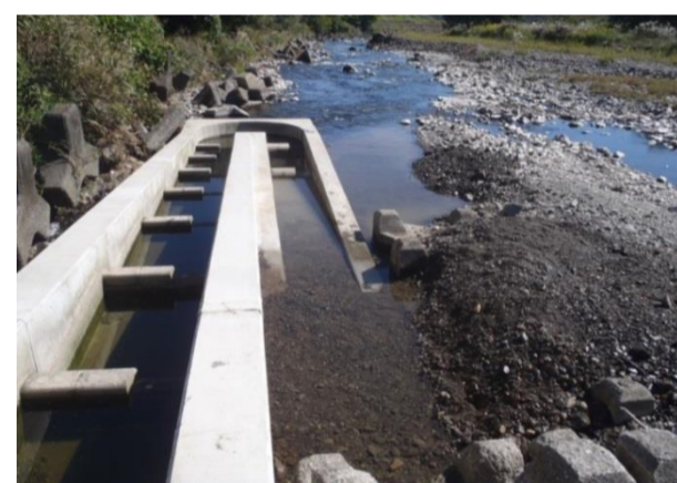
○魚道の修繕状況【藤古川(大垣市) 左:堆積土砂除去前 右:堆積土砂除去後】
