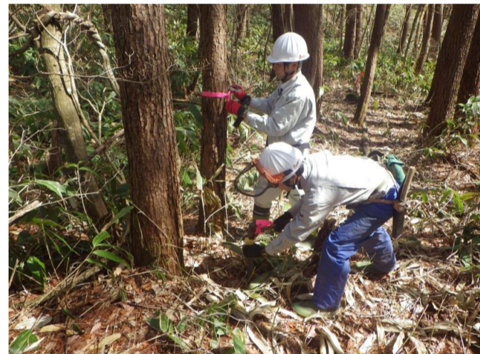
現地調査(杭打ち)
