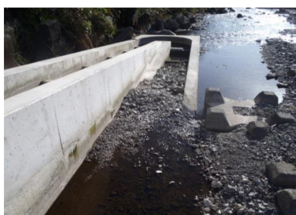
○魚道の修繕状況【藤古川(大垣市) 左:堆積土砂除去前 右:堆積土砂除去後】
