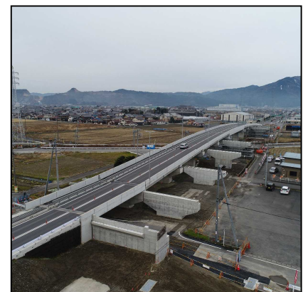
(主) 岐阜関ヶ原線 丈六道工区工事状況
