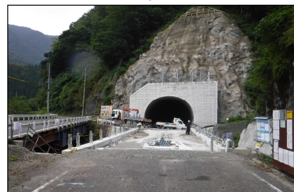
(国) 417号 横山鶴見バイパス工事状況
