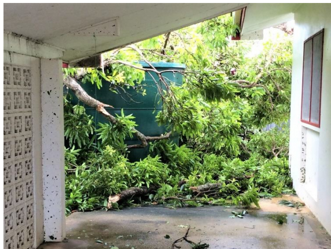
<倒木により損傷した自宅の雨水タンク>
