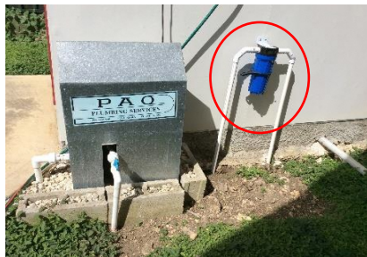
👉 新たに設置されたフィルター
