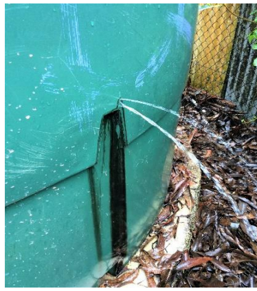
👉 雨水タンクに生じていた亀裂
