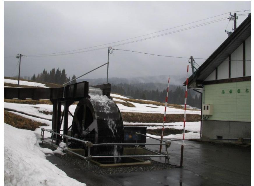
小水力発電(大)[上掛け水車型。750ワット。 落差3m]
