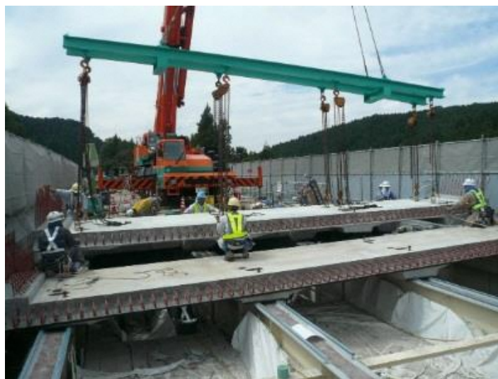
写真-参3.1.1 プレキャストPC床版の架設
