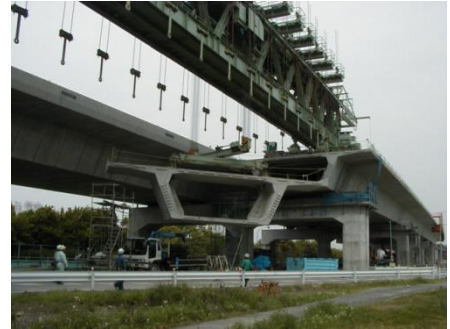
(4) プレキャストセグメントの架設
