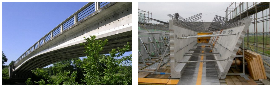
写真-参 3.2.1 プレテンション・プレキャストウェブ橋の施工例
