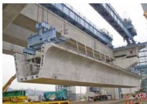
写真-解 4.2.2 U型コア断面の施工例 5)
