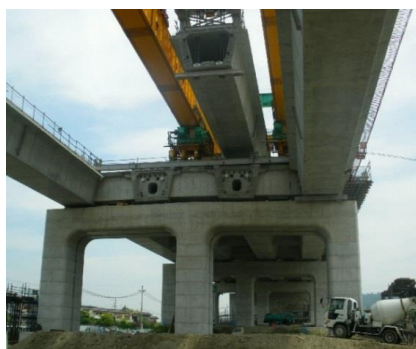
写真-解 4.2.1 箱型コア断面の施工例 5)
