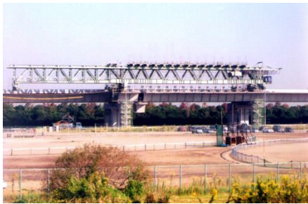
(5) プレキャストセグメントの架設
