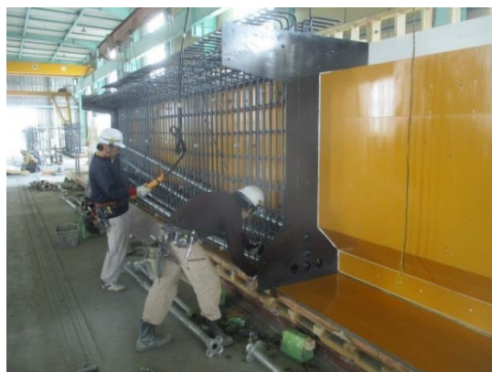
写真-解 3.4.5 コンポ桁鉄筋への適用事例
