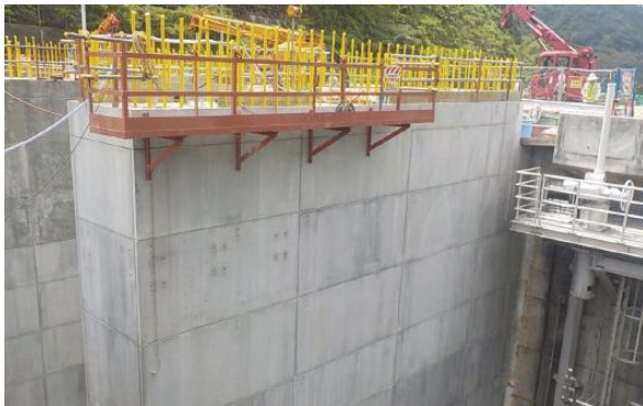
コンクリートダム（取水設備）
