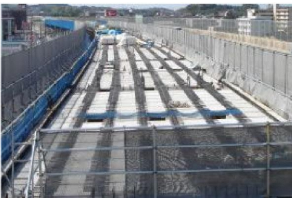
橋梁上部工（コンクリート製 PC 床版）
