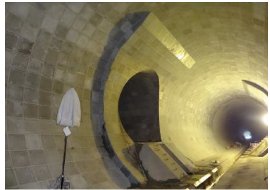
トンネル覆工
