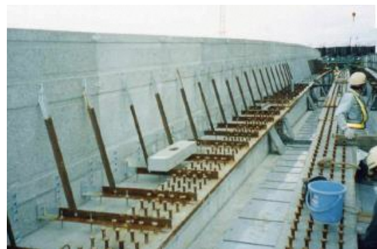
橋梁上部工（高欄，床版）
