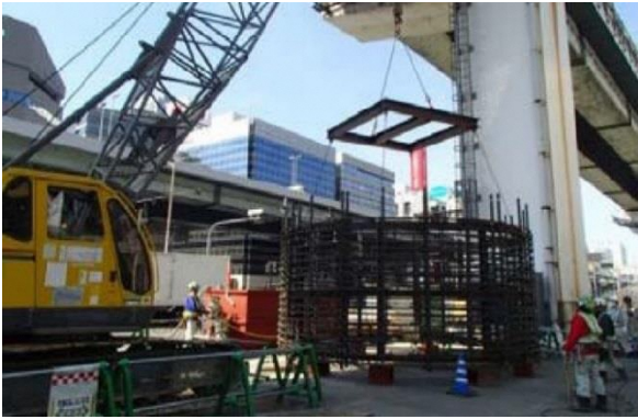
写真-解 3.4.1 ケーソン基礎への適用事例
