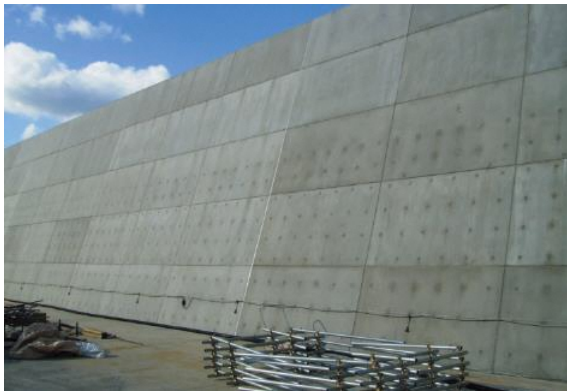
防波堤，防潮堤
