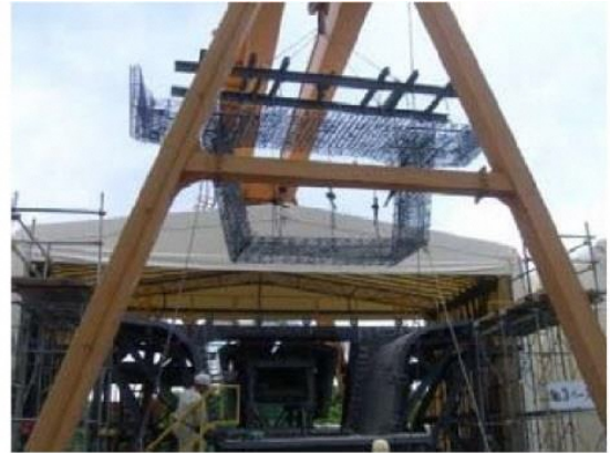
写真-解 3.4.3 プレキャストセグメントへの適用事例
