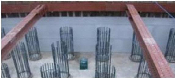
橋脚（フーチング）
