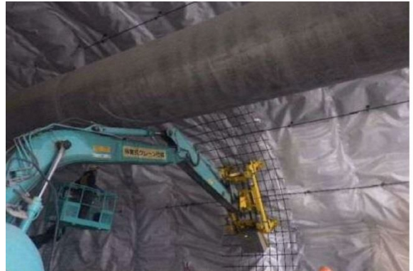
写真-解 3.4.2 トンネル覆工への適用事例
