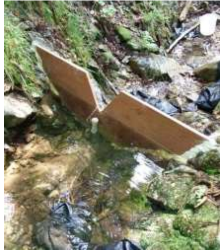
(量水堰) (水位(水圧)計測)
