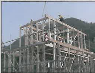
県産材住宅の上棟
