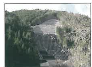
土砂崩壊箇所の復旧(郡上市)
