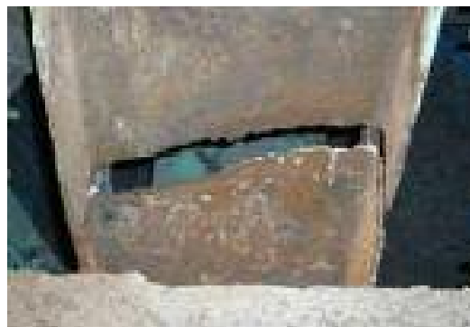
国道7号本荘大橋斜材の破断（2007年8月 秋田県 1966年建設）
