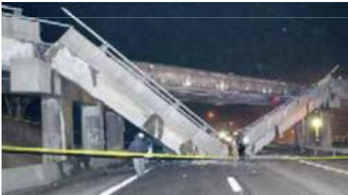
ペンシルベニア州I-70跨道橋落橋(2005年5月)
