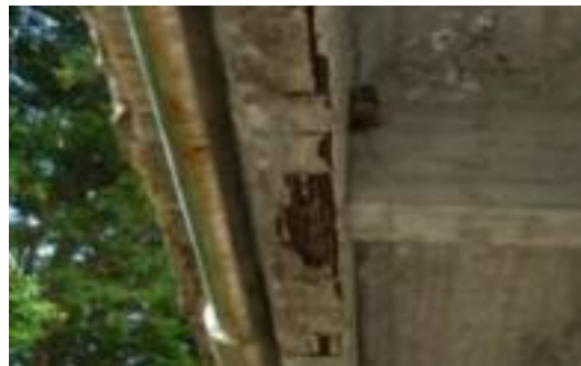
対症療法的修繕を実施する破損状況（塗装）
