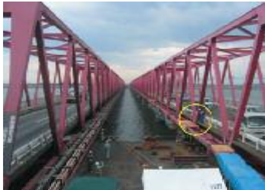
国道7号本荘大橋斜材の破断（2007年8月 秋田県 1966年建設）
