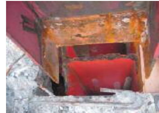
国道7号本荘大橋斜材の破断（2007年8月 秋田県 1966年建設）
