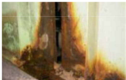
対症療法的修繕を実施する破損状況（塗装）
