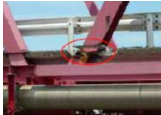
国道7号本荘大橋斜材の破断（2007年8月 秋田県 1966年建設）
