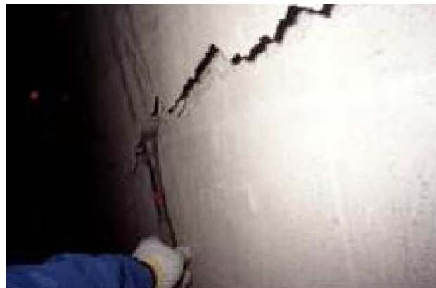
写真 2.2-3 ひび割れ部の段差の監視状況
