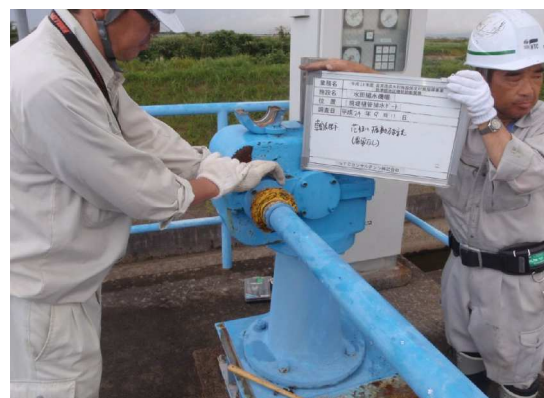
写真 2.3-2 開閉装置の振動確認
