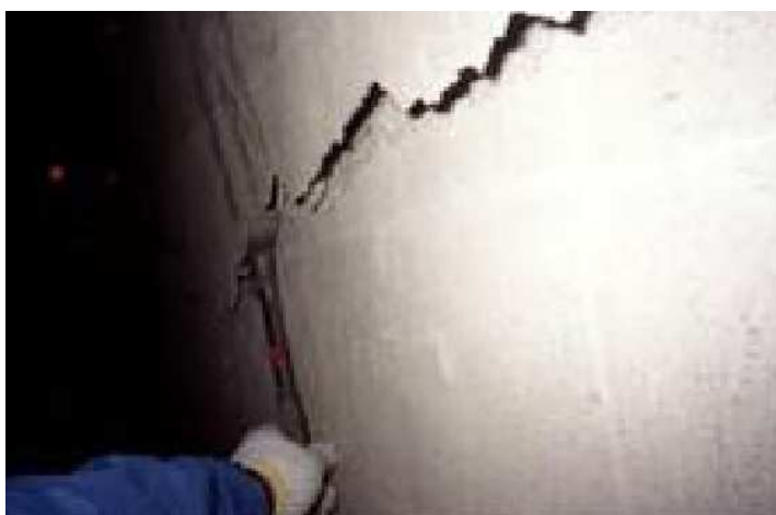
写真 2.2-6 ひび割れ部の段差の監視状況
