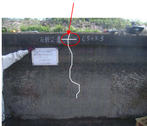
写真 2.2-2 ひび割れの監視状況
