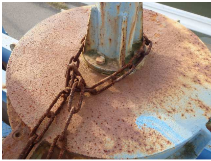
開閉装置の腐食
