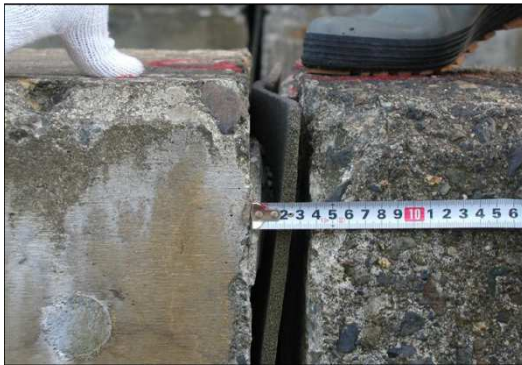
目地材の硬化
