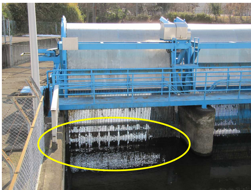
【水没状態にあるスクリーン、受桁、フレーム等の確認】
