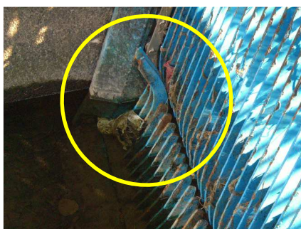
【水没状態にあるチェーン及びsprocket（歯車）、ガイドレールの確認】
