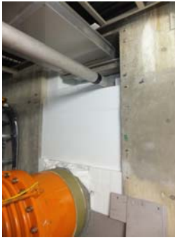
貫通口閉止処理
