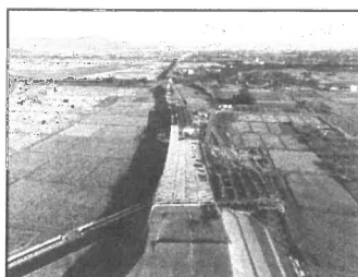
工事が進む東海環状自動車道 養老 JCT～養老 IC
