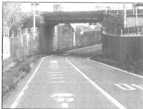
〔(一) 養老垂井線 垂井アンダーパス (垂井町)〕
