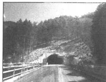
(主) 金山明宝線 (仮称) めいほうトンネル整備状況
