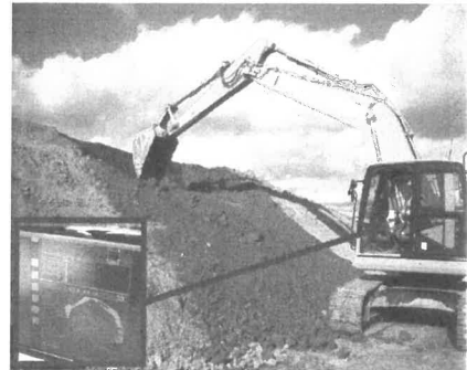
〔ICTを活用した施工例〕
