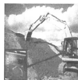
[ICTを活用した施工例]
