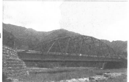
計画に基づく補修 (橋梁塗装)
