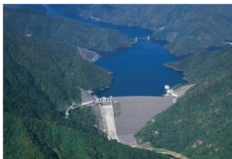
総貯水容量日本一の徳山ダム
