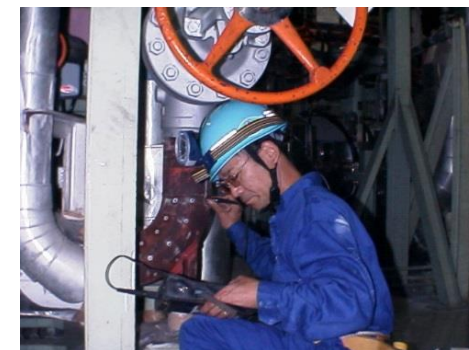
配管減肉の点検状況
