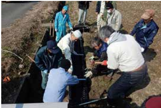
設置状況(大垣市川口町地内)
