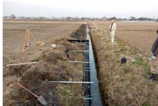
設置状況(海津市南濃町地内)
