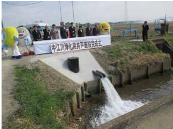
中江川浄化用井戸施設完成式
