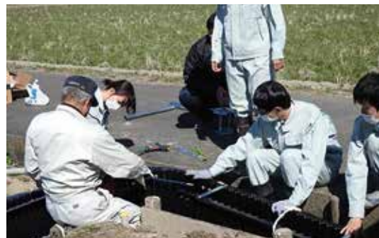
現場研修(生徒による魚道の設置)
