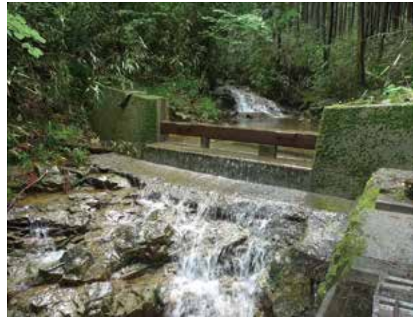
上流の水源地域内で約19haの森林が公有化された 取水施設(八百津町)
