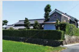
水屋建築の臼井医院 水都 水害の多い地域では輪中が形成される。敷地には水屋が建てられ水害に備えた様々な工夫が住宅にも施された。
