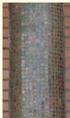
▲総タイルの丸柱
