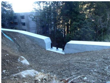
流木止めを設置した既存治山ダム
