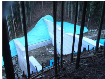
既存治山ダムの嵩上げ
