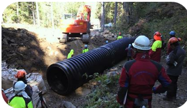
＜森林作業道現地検討会（高山市）＞
