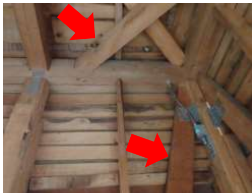
筋かい、火打ちの設置
