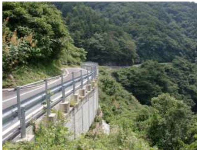
復旧町道付近
