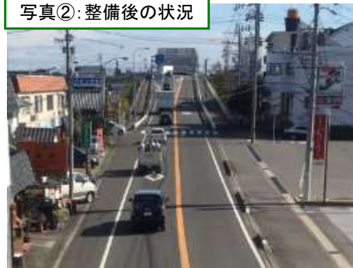
写真②: 整備後の状況
