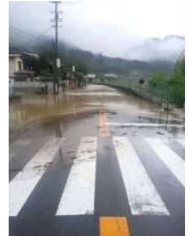
H26.8洪水 浸水状況 (高山市国府町地内)
