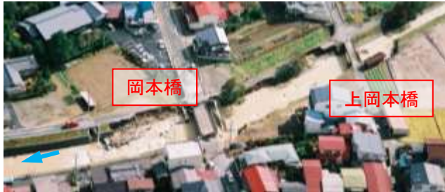
H16.10出水 被災状況
