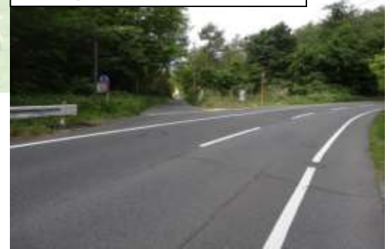
写真③(終点部付近の状況)
