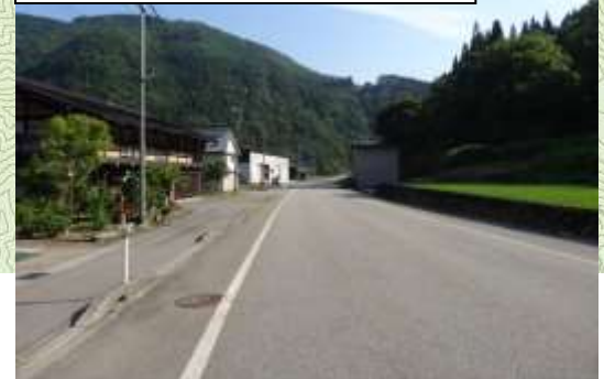
写真③(終点部付近の状況)
