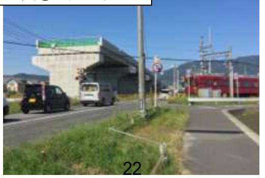
写真②: 踏切部付近
