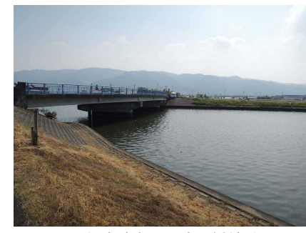
調査地点9: 七本戸橋付近
