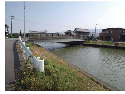
調査地点8: 渡橋付近
