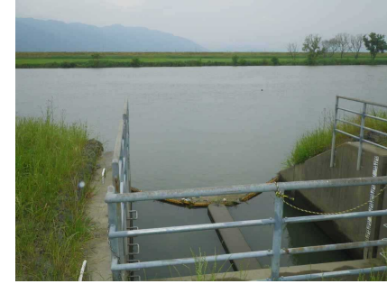
調査地点A: 揖斐川取水地点 (中江揚水機場取水地点)
