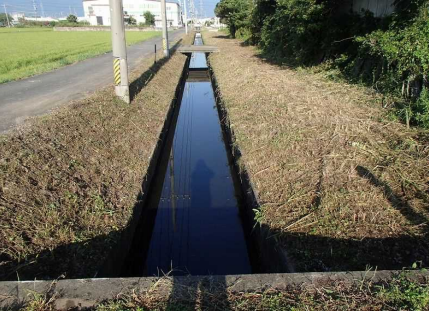
調査地点d: 今尾市街地排水路
