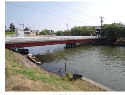
調査地点9': 辛亥橋
