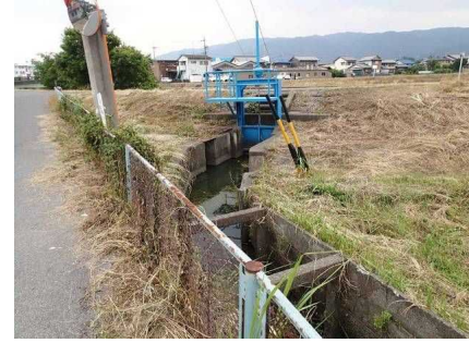
調査地点b: 流入水路 (地点8付近)
