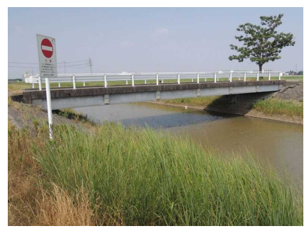
調査地点0': 新江橋付近
