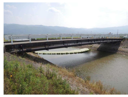
調査地点3: 赤池橋付近
