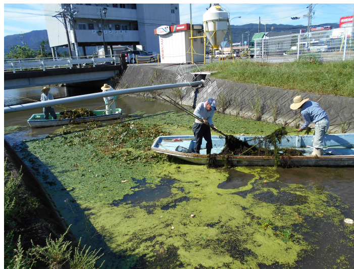
水草除去実施状況 (H27)
