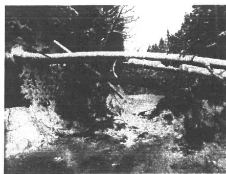
県管理道路で発生した倒木
