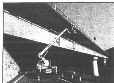
定期点検・修繕計画の整備 (跨道橋)
