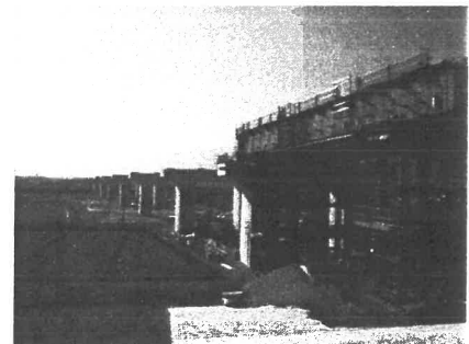
工事が進む東海環状自動車道養老 JCT～養老 IC
