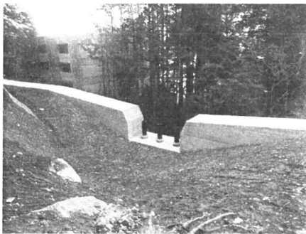
流木止めを設置した既存治山ダム
