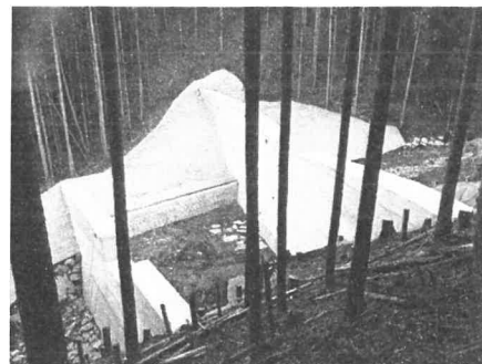
既存治山ダムの嵩上げ
