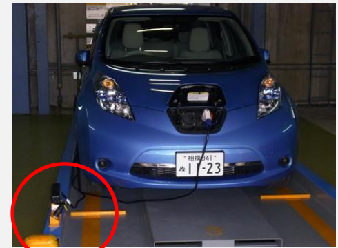
充電用コンセント
